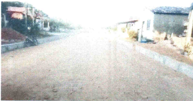
Imagem 04: Execução de guia (meio fio), confeccionado em concreto pré-moldado.
