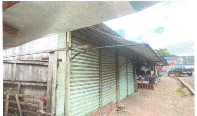
FOTO 4: VISTA LATERAL ESQUERDA
