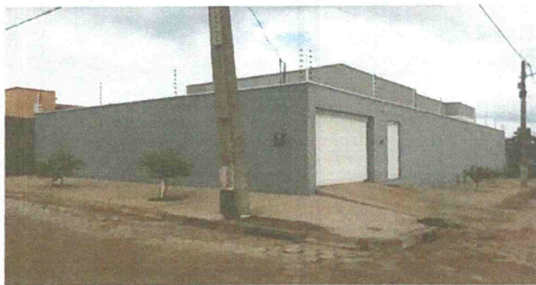
Imagem 02: Fachada Frontal e Lateral da obra
