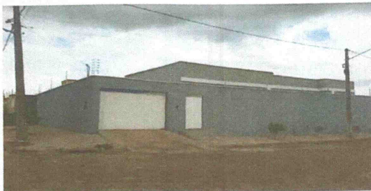
Imagem 01: Fachada Frontal da obra
