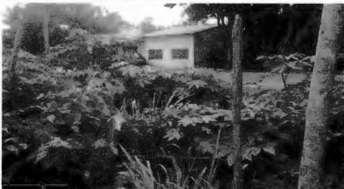
Terreno da Caema, na Vila Samara 2, está tomado por mato e tem tirado a tranquilidade de quem reside nas proximidades do lugar
