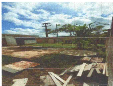
FOTO 5: Entulhos e infraestrutura existente
