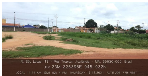
FOTOGRAFIA 04 : FACHADA POSTERIOR C/ COORDENADA
