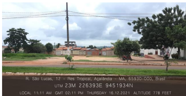
FOTOGRAFIA 02 : FACHADA FRONTAL C/ COORDENADA
