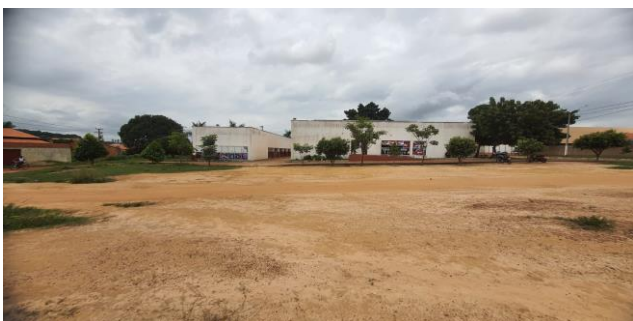
FOTOGRAFIA 05 : FACHADA LATERAL ESQUERDA
