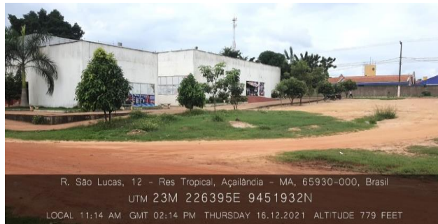
FOTOGRAFIA 06 : FACHADA LATERAL ESQUERDA C/ COORDENADA
