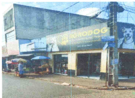
FOTO 1: AUSÊNCIA DE RAMPAS
