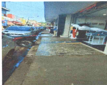
FOTO 6: AUSÊNCIA DE RAMPAS
