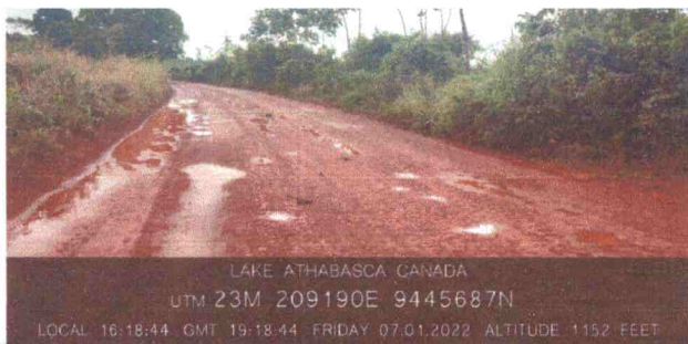
FOTO 7: DRENAGEM PLUVIAL COMPROMETIDA
