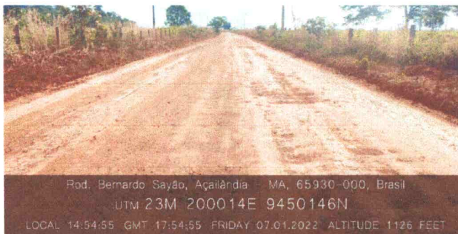
FOTO 4: ESTRADA DO KM 30
