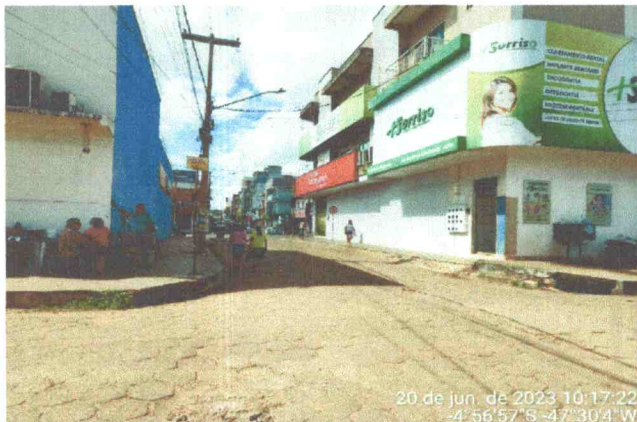
FOTO 1: AUSÊNCIA DE RAMPAS NO ACESSO AO PASSEIO
