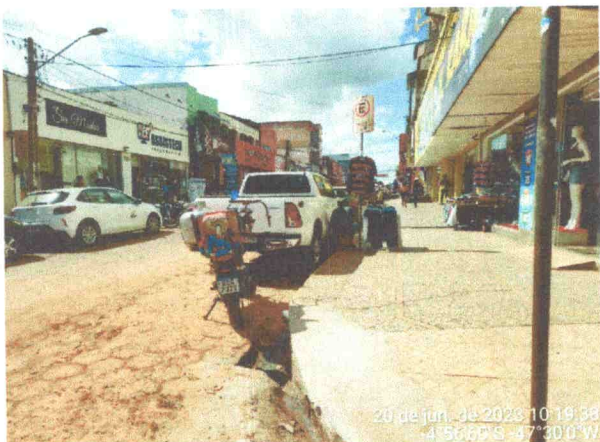
FOTO 7: VARIÇÃO DE NÍVEIS SEM ACESSIBILIDADE
