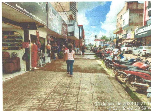
FOTO 8: VARIÇÃO DE NÍVEIS SEM ACESSIBILIDADE
