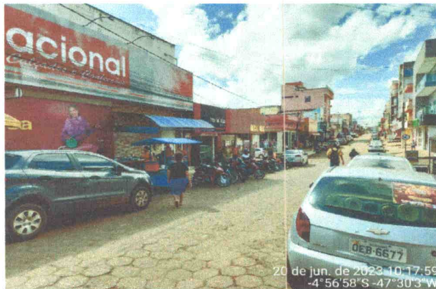
FOTO 2: AUSÊNCIA DE FAIXA DE PEDESTRES
