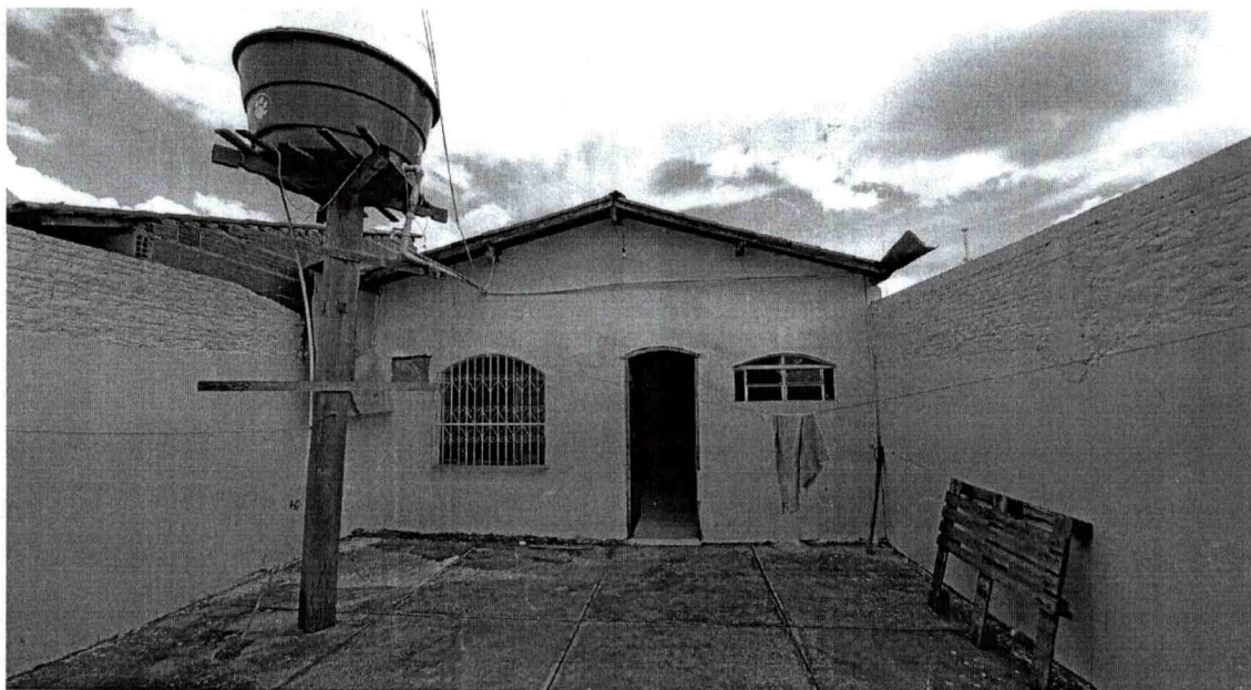
Figura 25 - AFASTAMENTO FUNDOS VISTA PARA ACESSO A COZINHA.
