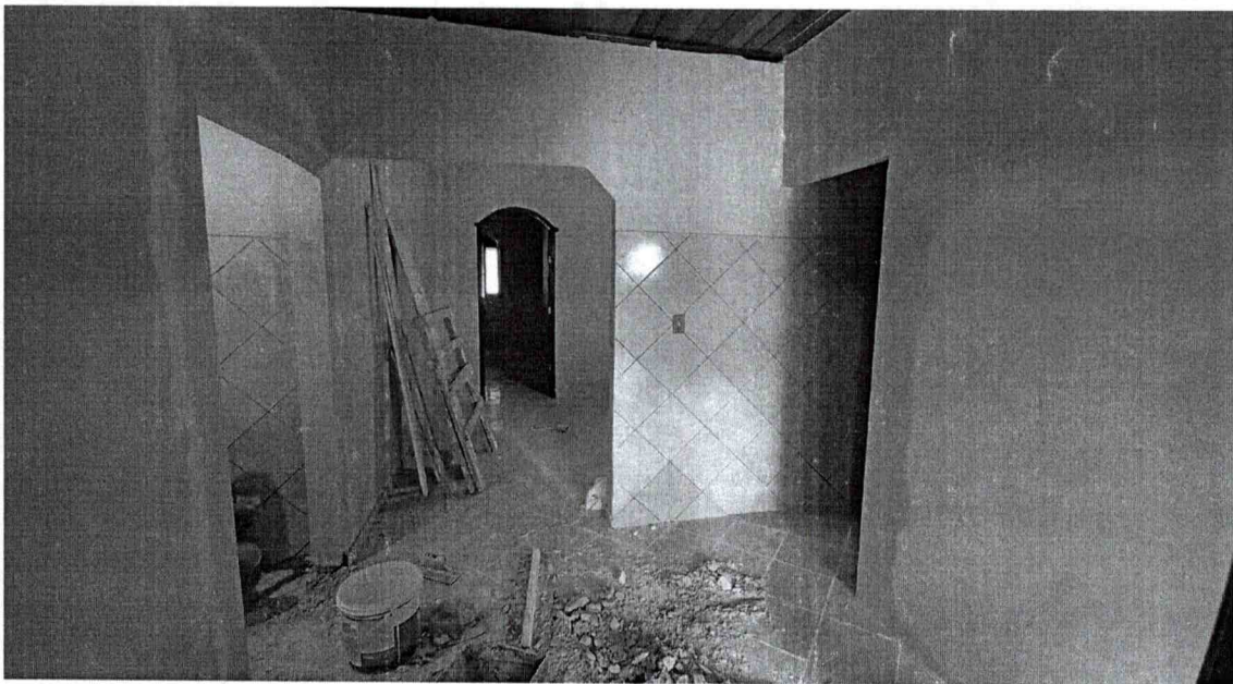
Figura 18 - HALL DE ACESSO - VISTA PARA BANHEIRO SOCIAL E SALA DE ESTAR.
