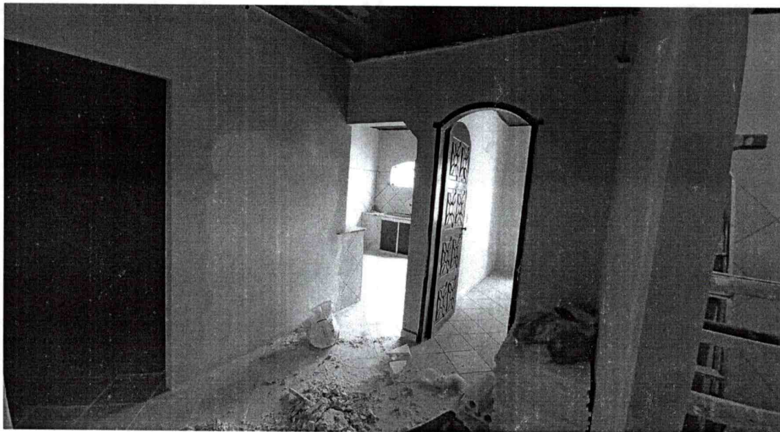
Figura 24 - HALL DE ACESSO VISTA PARA ENTRADA DA COZINHA, QUARTO E DESPENSA.
