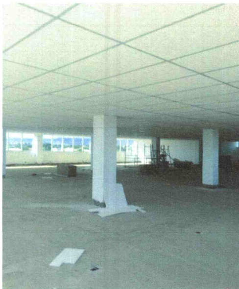
Figura 9 execução do forro mineral
