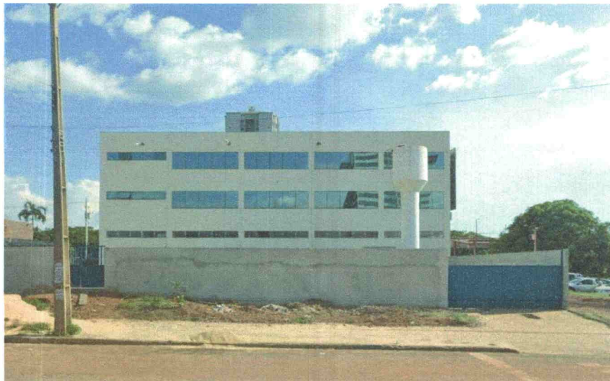
Figura 13 fachada do fundo
