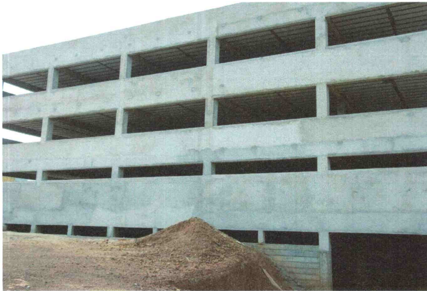
Figura 4 Requadro das Janelas
