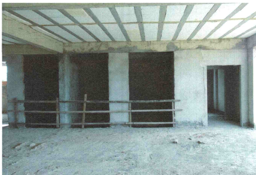
Figura 6 Requadro dos vãos de elevador
