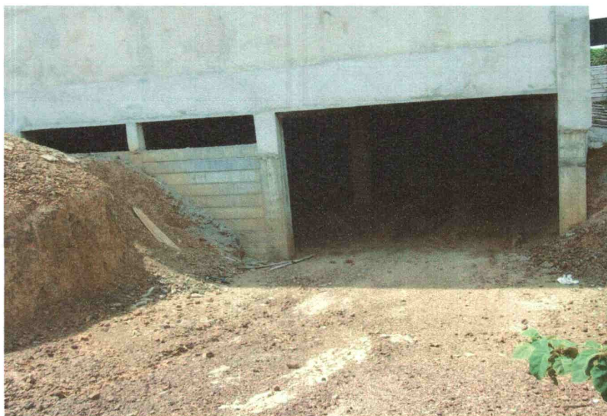
Figura 2 Execução do subsolo
