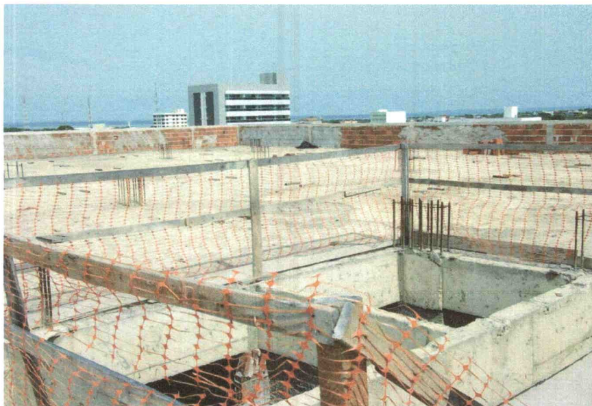
Figura 7 Execução da platibanda
