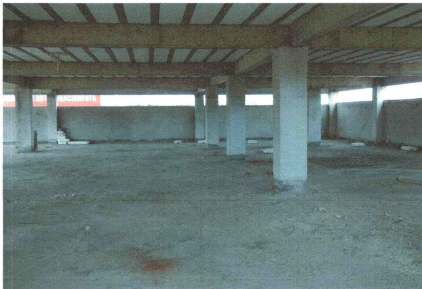
Figura 5 Nivelamento do piso
