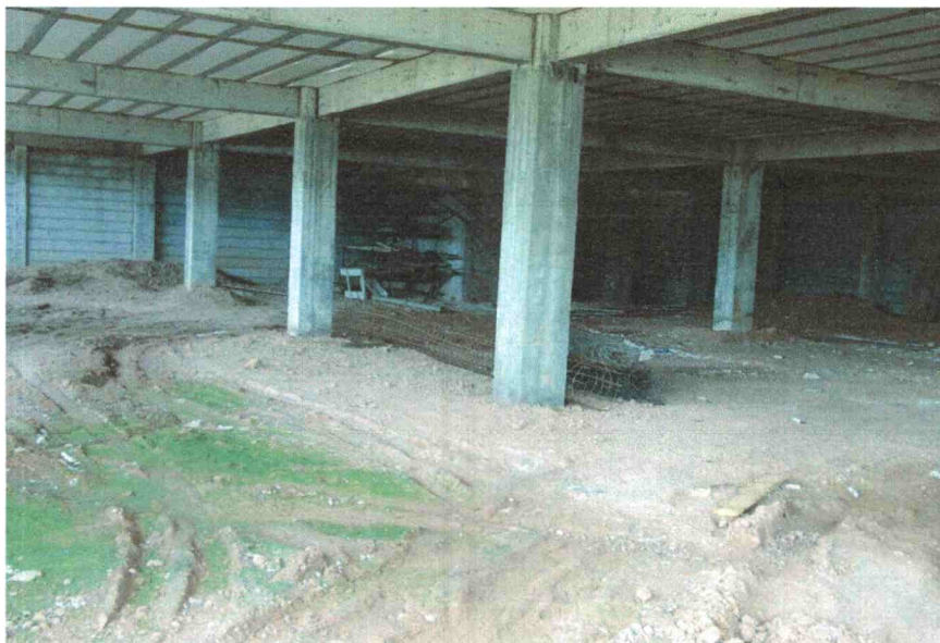
Figura 1 compactação do subsolo
