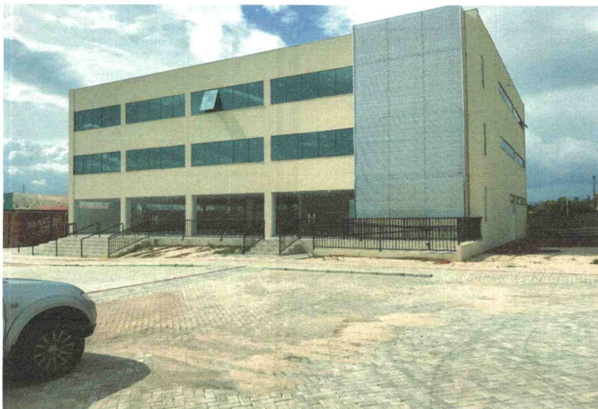
Figura 12 montagem do brise metálico
