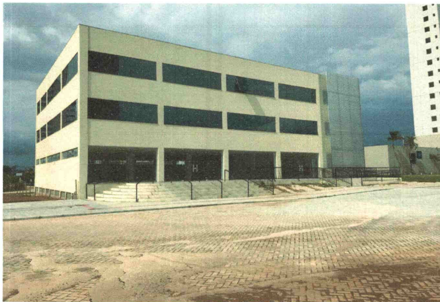
Figura 11 montagem da pele de vidro e pintura
