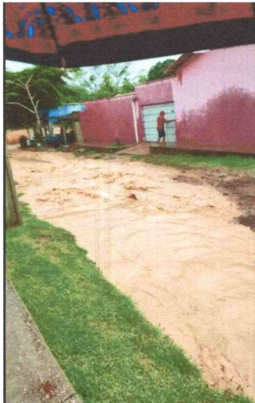
Via pública destruída pelas chuvas
