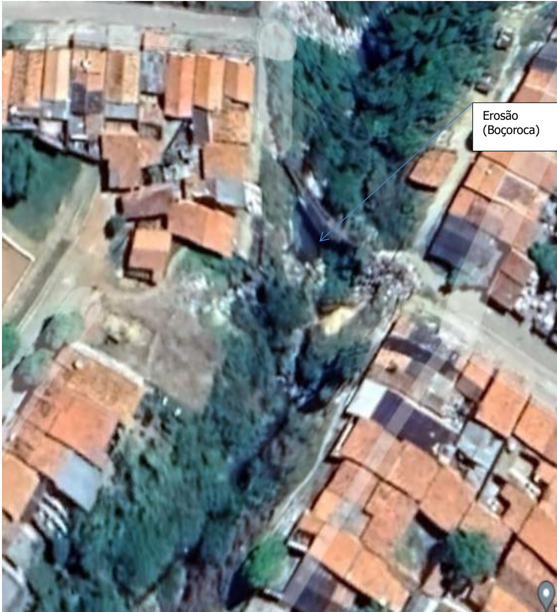
Fig. 1 – Erosão provocada em corpo hídrico próximo à Rua do Campo – Açailândia - MA
