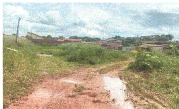
FOTO 9: VISTA LATERAL DIREITA
