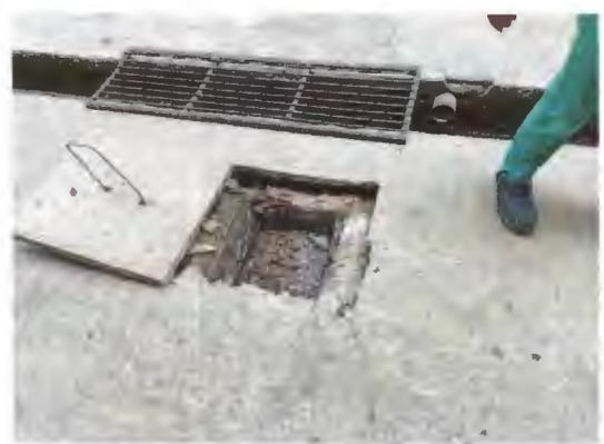
Foto 3.3: Caixa de inspeção
