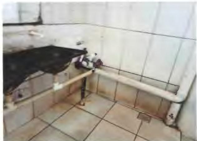
Foto 2.4: Tubulação de esgoto do lavatório
