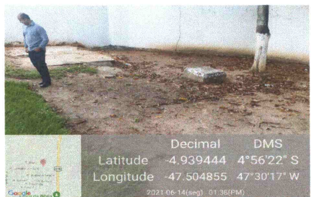
Foto 1: Local de perfuração do poço
