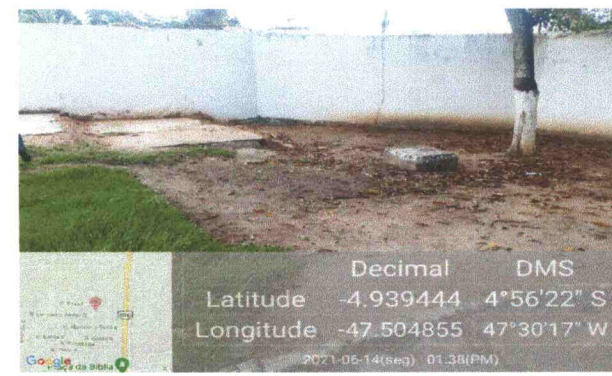
Foto 4: Local de perfuração do poço
