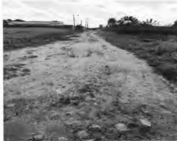
FOTO 21 – RUA SÃO LUCAS
