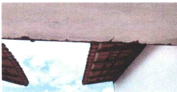
Foto 28: Laje de cobertura da área de circulação
