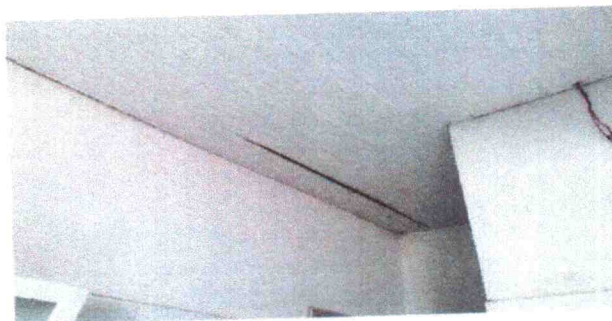
Foto 12: Parte da cozinha forrada em PVC
