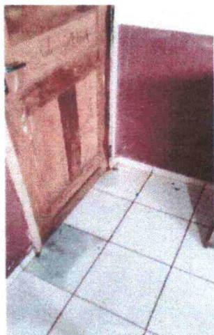
Foto 29: Piso nos quartos
