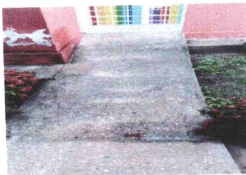
Foto 8: Acesso a parte da brinquedoteca no bloco adm
