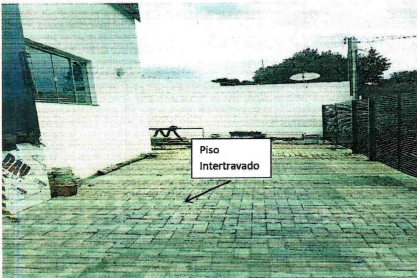
Figura 2- Piso Intertravado
