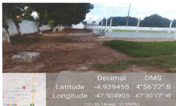
Foto 3: Local de perfuração do poço
