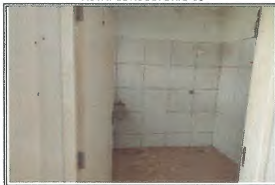
VISTA: BANH. DA SALA DE OBSERVAÇÃO
