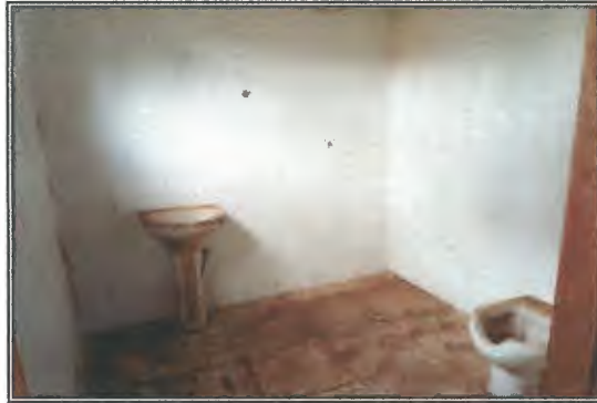
VISTA: BANHEIRO PNE
