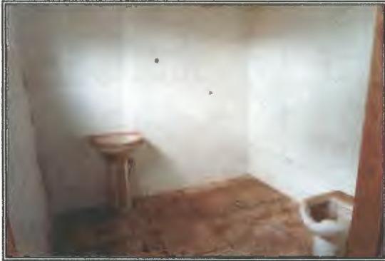
VISTA: SANITÁRIO SL. DE OBSERVAÇÃO
