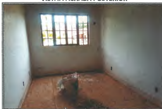
VISTA: SALA DE ADMINISTRAÇÃO
