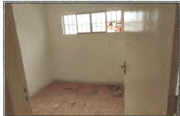
VISTA: SALA DE ADMINISTRAÇÃO
