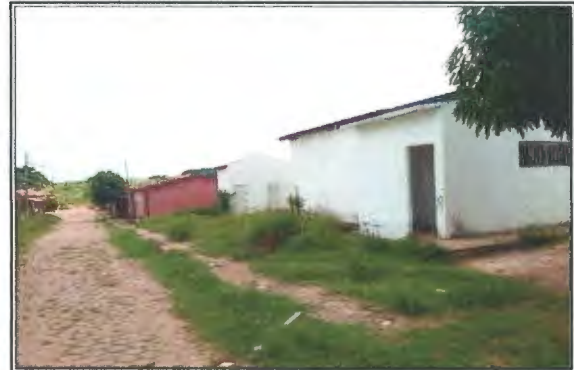
VISTA: FACHADA LATERAL ESQUERDA
