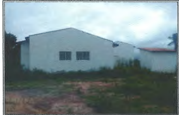
VISTA: FACHADA POSTERIOR
