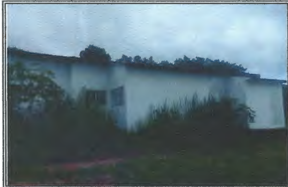
VISTA: FACHADA LATERAL ESQUERDA
