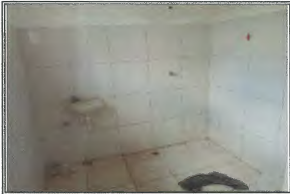
VISTA: BANH. DA SALA DE OBSERVAÇÃO
