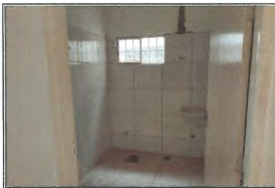
VISTA: BANHEIRO PNE
