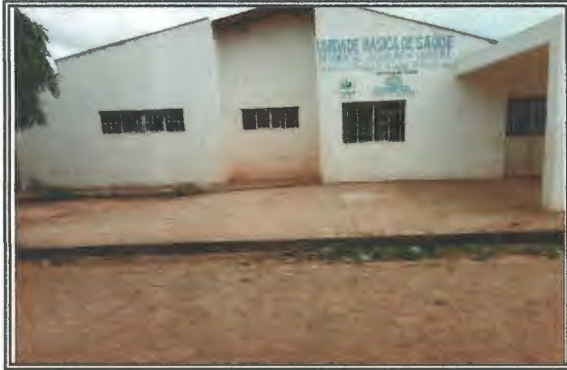
VISTA: FACHADA PRINCIPAL
