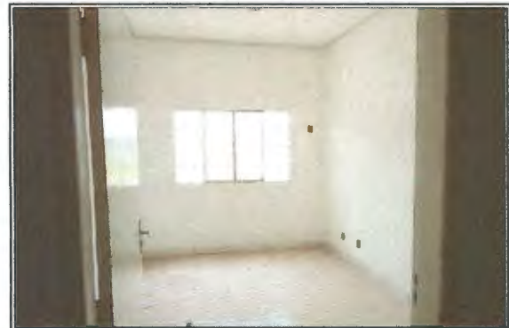
VISTA: SALA DE ADMINISTRAÇÃO
