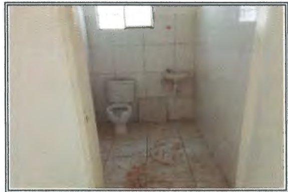
VISTA: BANHEIRO PNE
