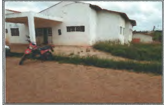
VISTA: FACHADA PRINCIPAL
