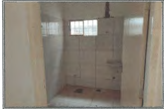
VISTA: BANHEIRO PNE
