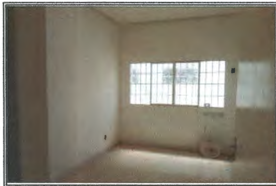
VISTA: SALA DE CURATIVO
