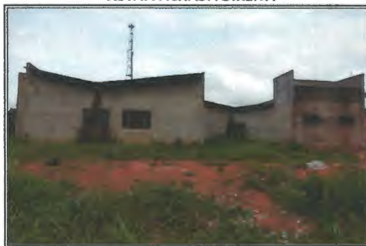
VISTA: FACHADA POSTERIOR
