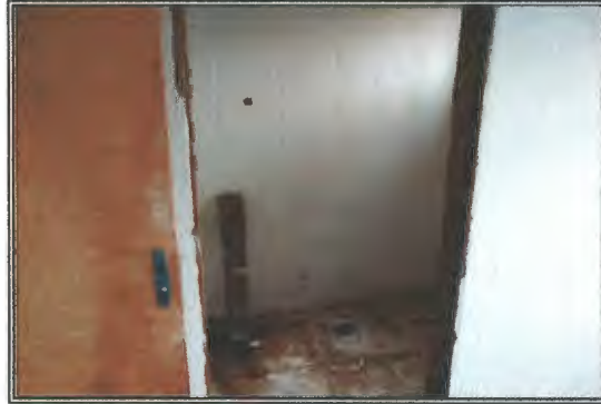
VISTA: SANITÁRIO CONSULTÓRIO 2
