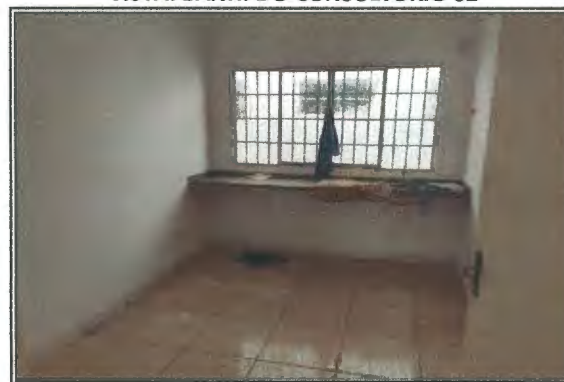
VISTA: SALA DE CURATIVO
