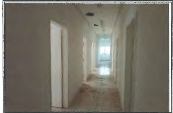
VISTA: CORREDOR A DIREITA
