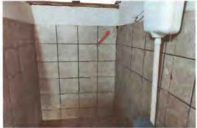
Fotografia 14. Banheiro com necessidade de substituir torneira onde deve ser instalado chuveiro.
