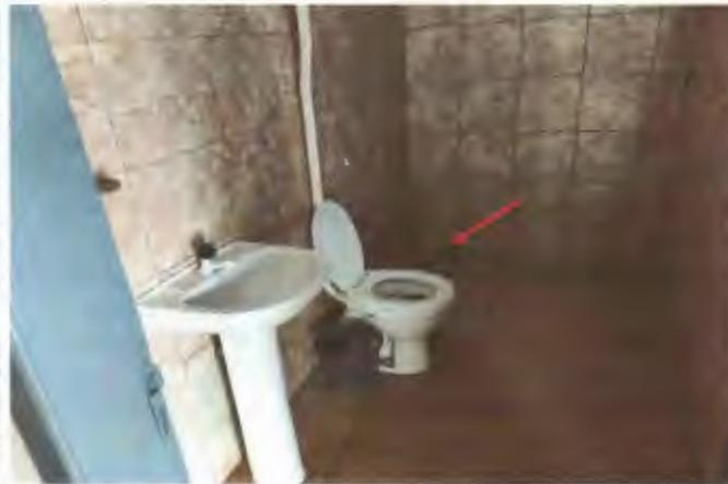
Fotografia 15. Banheiro com presença de odor proveniente da instalação sanitária. Necessidade de reparo.
