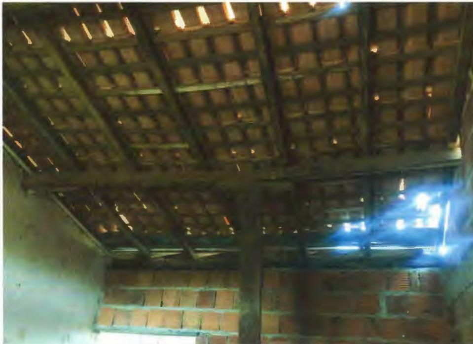
SALA 02 – ASSOCIAÇÃO – MADEIRAMENTO DO TELHADO QUEBRADO
