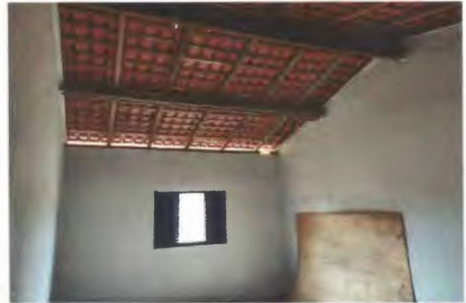
Fotografia - 07, 08, 09 e 10. Na Sala 02 (Associação) foram executados revestimentos com massa única nas paredes da sala e execução de pintura de paredes, janelas e portas. Execução de contrapiso e substituição de peça de madeira da cobertura que apresentava deterioração. Porém há ausência de instalação elétrica.
