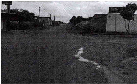
FOTO 06 – RUA RAIMUNDO PIMENTEL
