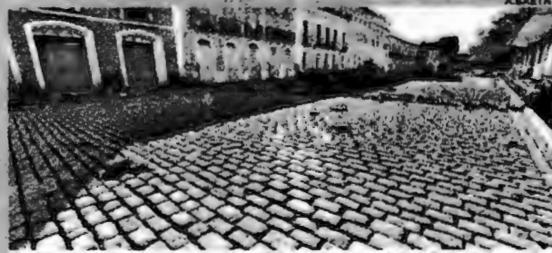
Prefeitura já iniciou a colocação de paralelepípedos no trecho em frente ao Largo do Carmo
