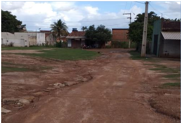
FOTO 33 – RUA DA PRAÇA A
