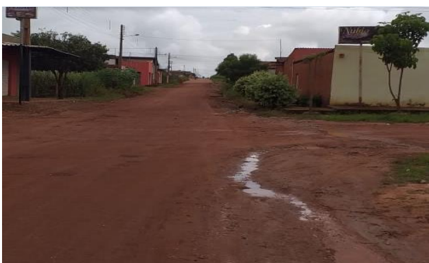
FOTO 06 – RUA RAIMUNDO PIMENTEL
