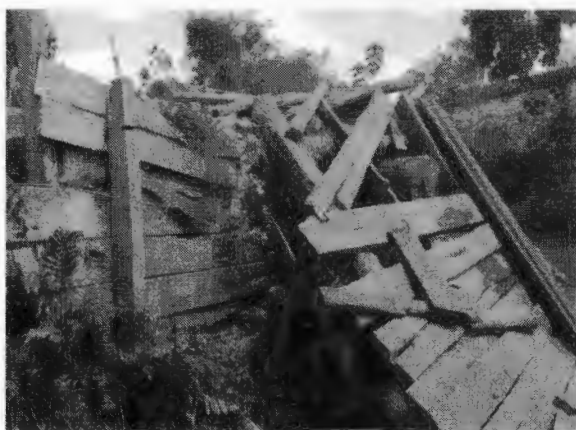
Vista lateral do apoio da ponte de madeira existente com estrutura perdida
